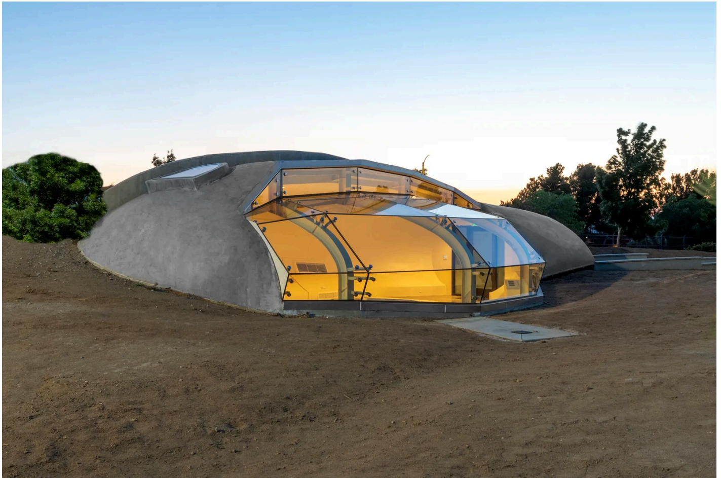
Le nouveau dôme Shri Amma, conçu avec une forme semblable à celle de la matrice, cherche à inviter la contemplation avec ses courbes douces et ses fenêtres de verre. © Courtesy of CSA Partners / Jill Weller
